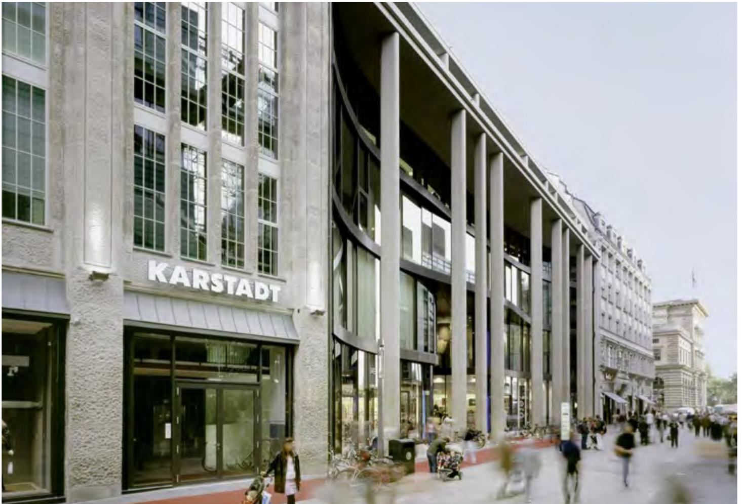
—— Einladende Eingänge und breite Wege münden in einen zentralen glasüberdachten Lichthof. Die klare vertikale und horizontale Gliederung der Altbaufassaden wird einerseits durch freistehende, ovale Schleuderbetonstützen fortgeführt, andererseits durch die Gesimse bestimmt. Die Schaufenster rund um die Altbaufassaden im Erdgeschoss bestehen aus einer thermisch getrennten Leichtmetall-Pfosten-Riegelkonstruktion, die in der Ebene der Bestandsstützen an den Baukörper angeschlossen ist.
