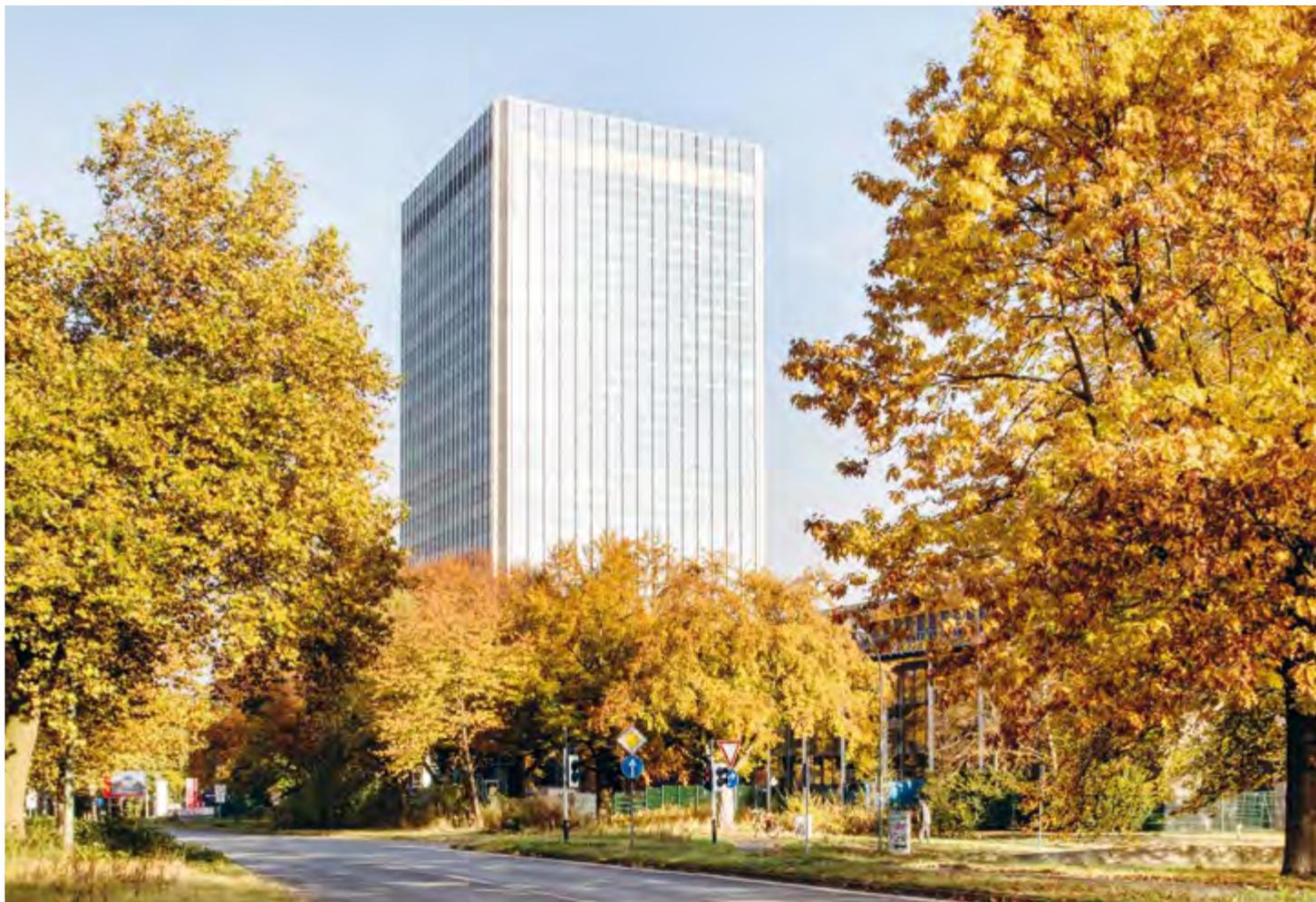
—— Die Fassadensanierung inklusive einer Schadstoffsanierung führten wir im laufenden Bürobetrieb durch. Auf insgesamt 10.000 m<sup>2</sup> Fassadenfläche tauschten wir eine ineffiziente Konstruktion gegen eine moderne, elementierte Alu-Glasfassade.
