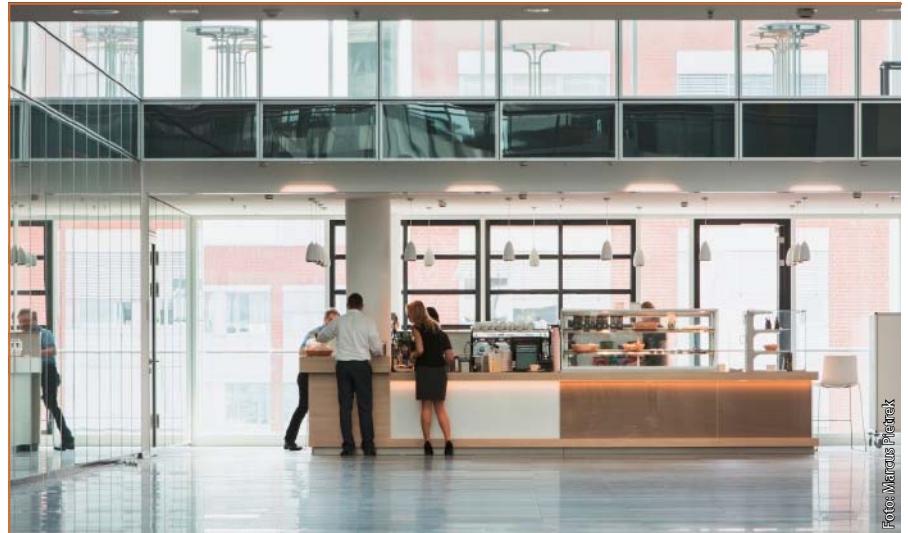
Abb. 5: Die Cafeteria innerhalb der Magistrale wird im Brandfall durch einen textilen Feuerschutzvorhang mit bauaufsichtlicher Zulassung abgetrennt.
